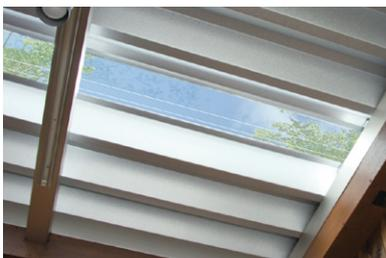
日中の陽射しの明るさを、ガレージ内に取り込むことが出来る透明屋根材。紫外線をカットする性質を持つポリカーボネート製です。
