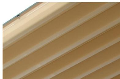
結露を軽減するポリエチレンフォームを屋根内側に張り付けた屋根材。
